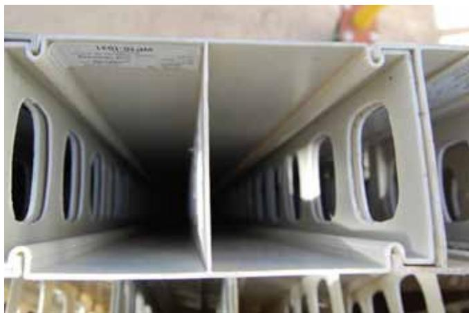
*Figura 12 - Detalhe do encaixe entre cada módulo do sistema construtivo.*
