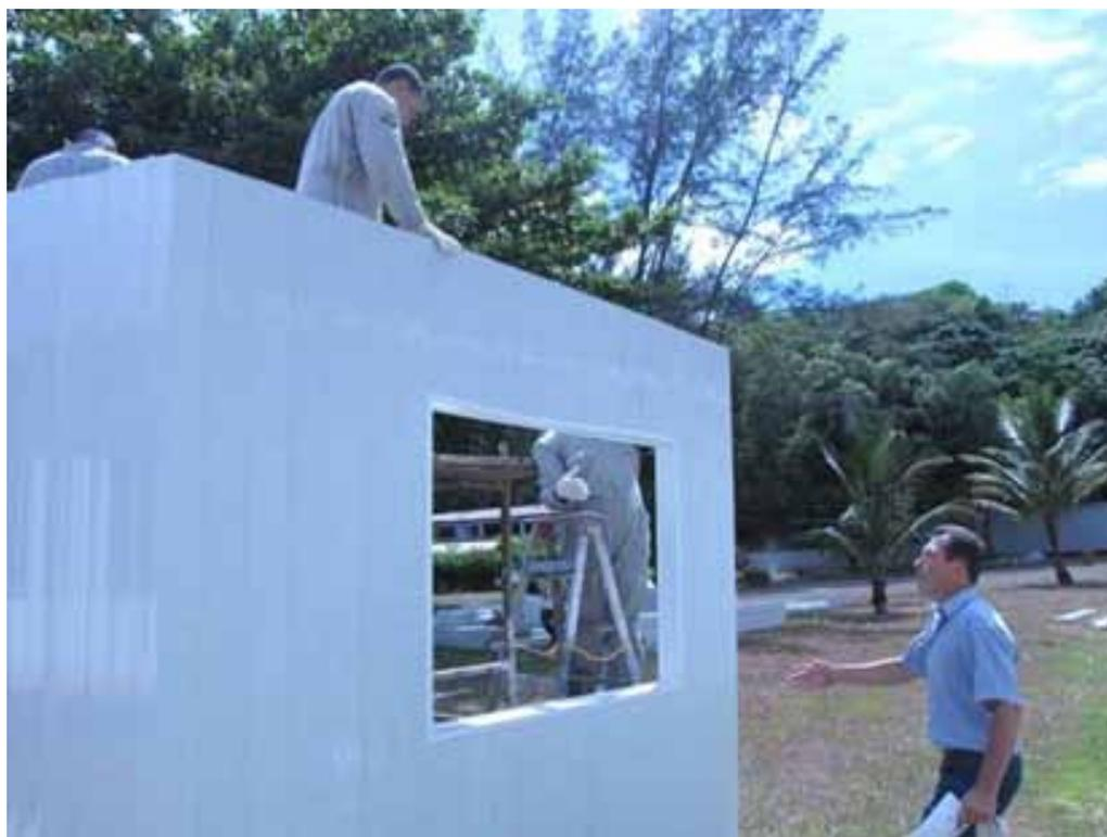
*Figura 14 - Montagem da parede de um dos dormitórios.*
