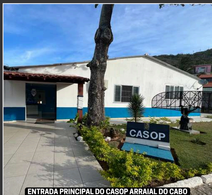
ENTRADA DA SEDE DO CASOP
