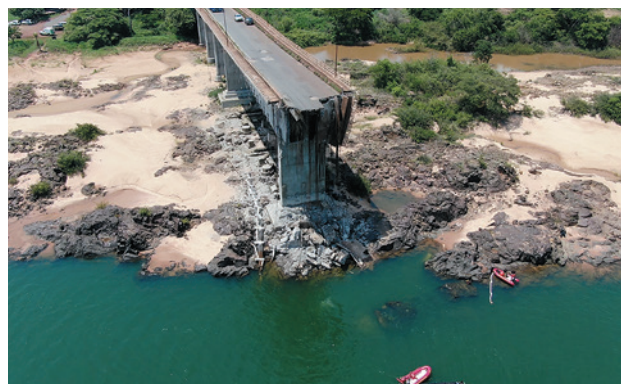
Figura 2: Vista aérea da ponte.
