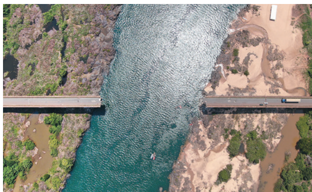
Figura 1: Vista aérea da ponte.
