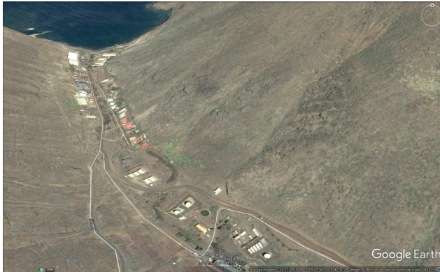
Figura 3 - Vista geral do Vale Rupert's
