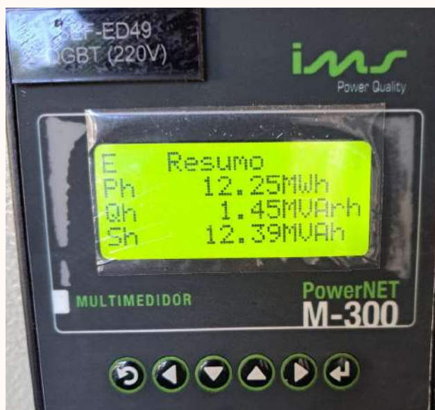
Figura 3: Medidor de Energia Digital do Ed. 49 Fonte: Autor
