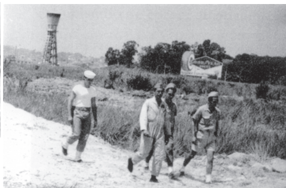
Inspeccionando a construção da pista: Capitão de Fragata Amaral, Primeiro-Tenente Lynch e Capitão de Corveta Hercul. A Avenida Brasil ao fundo, junto à torre
