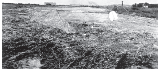
Pista em construção. No final da pista, o prédio da Escola da Marinha Mercante e à esquerda, o Hospital do Fundão
