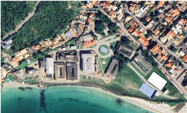
Figura 2 – Sede do IEAPM, com área total de 50 mil m 2 e área construída de 13,5 mil m 2
